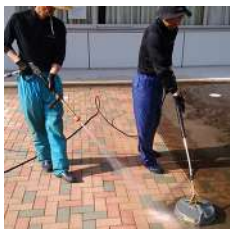
高圧洗浄作業
