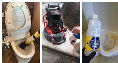
詰まりの内容によって、ローポンプでの詰まり除去から、排水管洗浄、便器脱着など必要な技術で対応します。また、必要に応じてカメラ調査も行います。小便器の尿石除去にも対応します。
